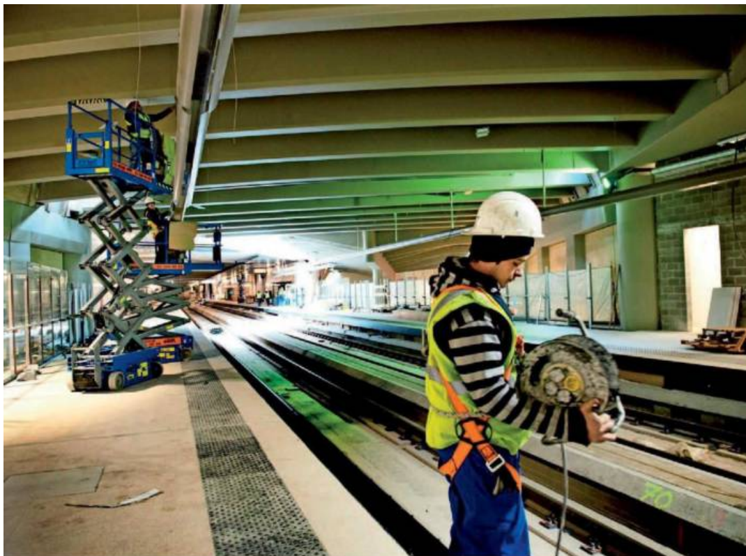
L'État lance de moins en moins de grands travaux (ici, le tunnel Schuman-Josaphat). © S. VANDERSTICHELE
